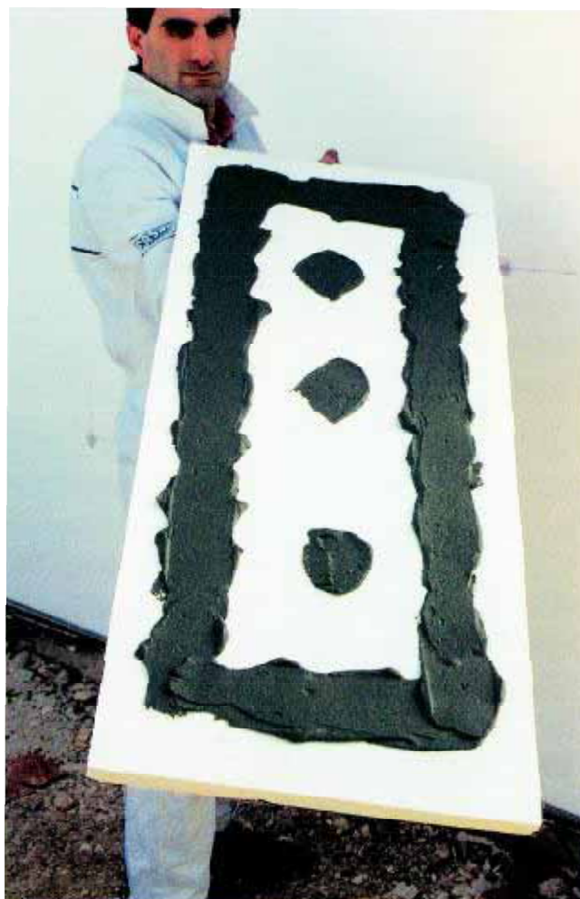
applicazione a strisce o a punti dell'adesivo per l'incollaggio dei pannelli
