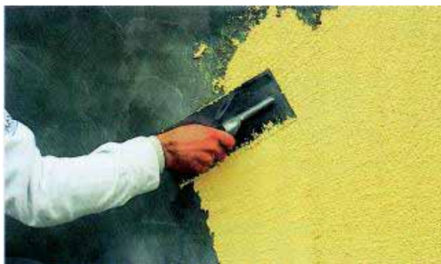
applicazione del rivestimento colorato
