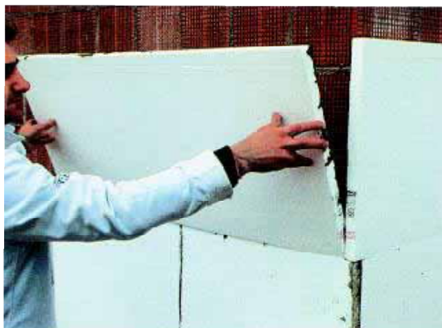
posa dei pannelli isolanti
