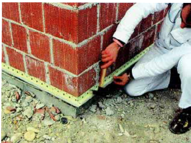
montaggio dei profili di partenza
