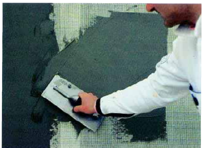
seconda mano di rasatura con applicazione della rete d'armatura
